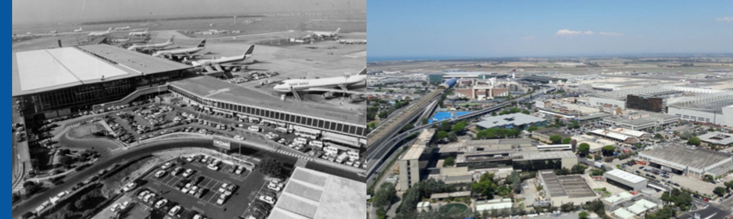
Foto aerea dell'infrastruttura aeroportuale, 1989 (a sinistra) e attuale (a destra)
