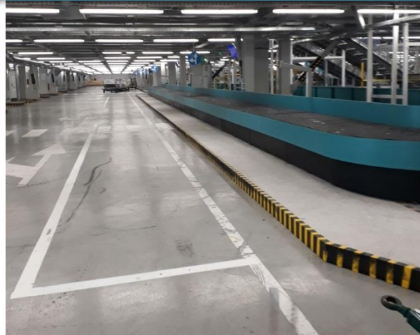
Inserimento 2° Carosello di Back-up con macchina RX BHS/HBS Terminal 1
